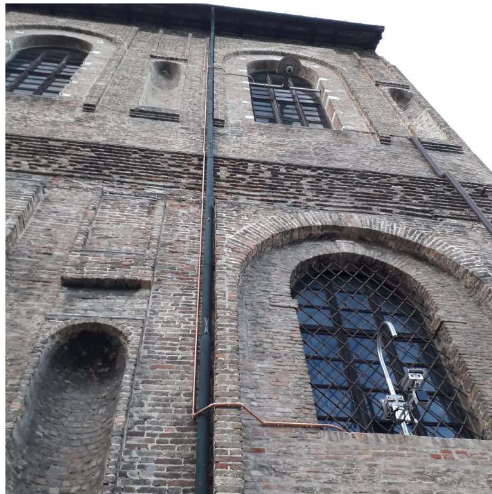
ESEMPIO DI TUBAZIONE IN RAME DA UTILIZZARE PER L'INSTALLAZIONE IN OGGETTO
