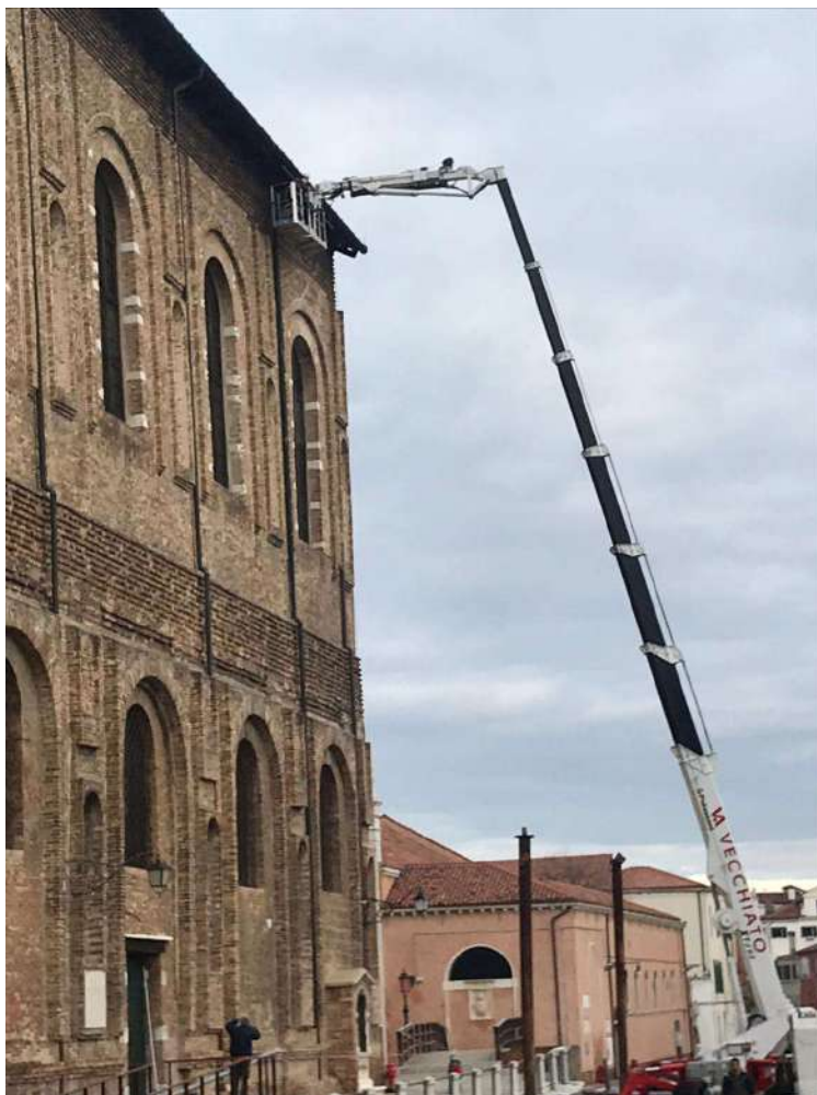
ESEMPIO DI LAVORAZIONE CON PER LA REALIZZAZIONE DI UNA INFRASTRUTTURA SU FACCIATA MEDIANTE CHIATTA DOTATA DI ELEVATORE
